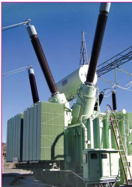
ЧАО «Запорожтрансформатор» (ЗТР) осуществил поставку шунтирующего реактора типа РТДН-120000/330-У1 с регулируемой реактивной мощностью для высоковольтных сетей Латвии AS «Augstsprieguma tīkls», ПС Aizkraukle.
