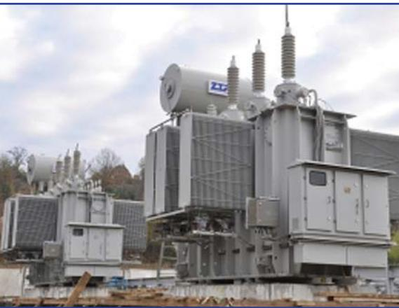
Строительство подстанции 110 кВ Временная (Резервная) началось в 2010 году. В настоящее время завершается строительство открытого распределительного устройства (ОРУ) 110 кВ, смонтировано модульное комплектное распределительное устройство (КРУМ) 10 кВ, а также микропроцессорные устройства релейной защиты и противоаварийной автоматики. Ввод объекта в эксплуатацию запланирован на первое полугодие 2012 года.
