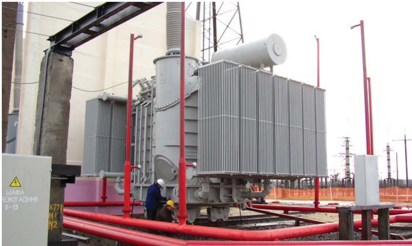
Монтажные работы выполняет шеф-инженеры Сервисного центра ОАО «ЗТР». Реактор ПОМ-110000/750. ПС «Западноукраинская».
